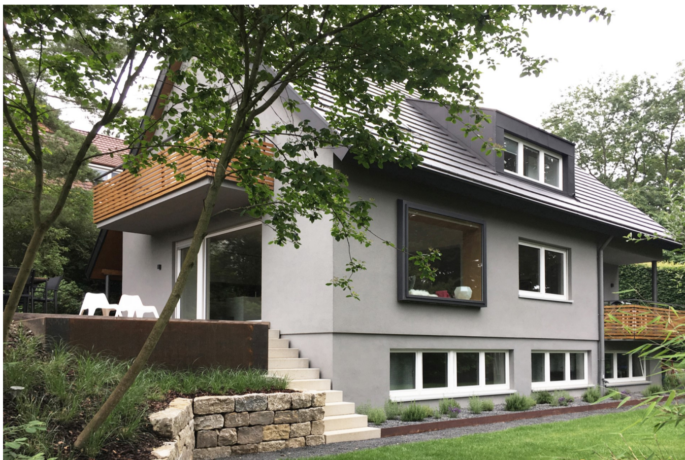
Foto: Thera Architekten
