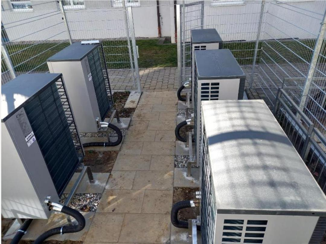
Mehrfamilien-Wohnblock mit Wärmepumpenkaskade und Spitzenlast-Gaskessel
