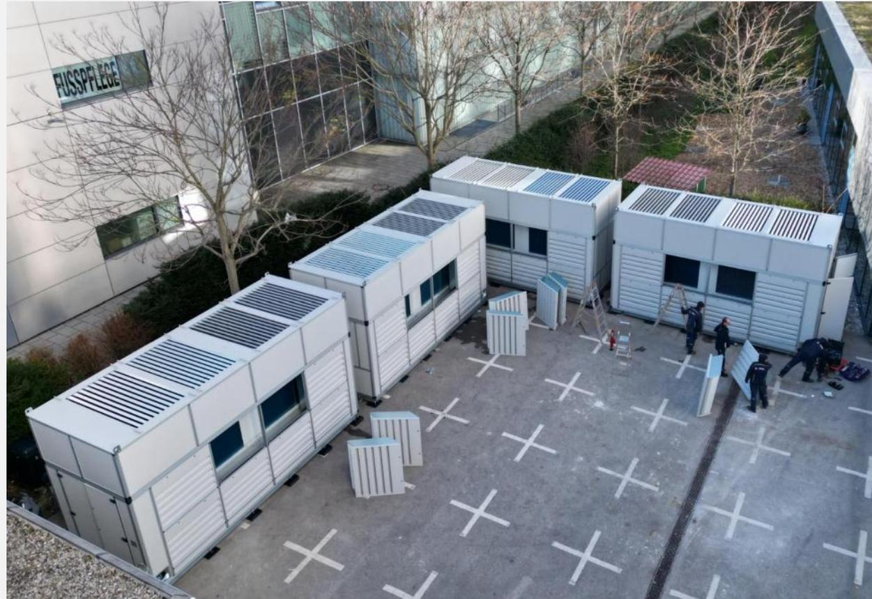
Hotelgebäude mit Wärmepumpenkaskade aus 4 Luft-Wasser-WPs und einer Wasser-Wasser-Wärmepumpe (unsanierter Altbau aus den 1970ern)
