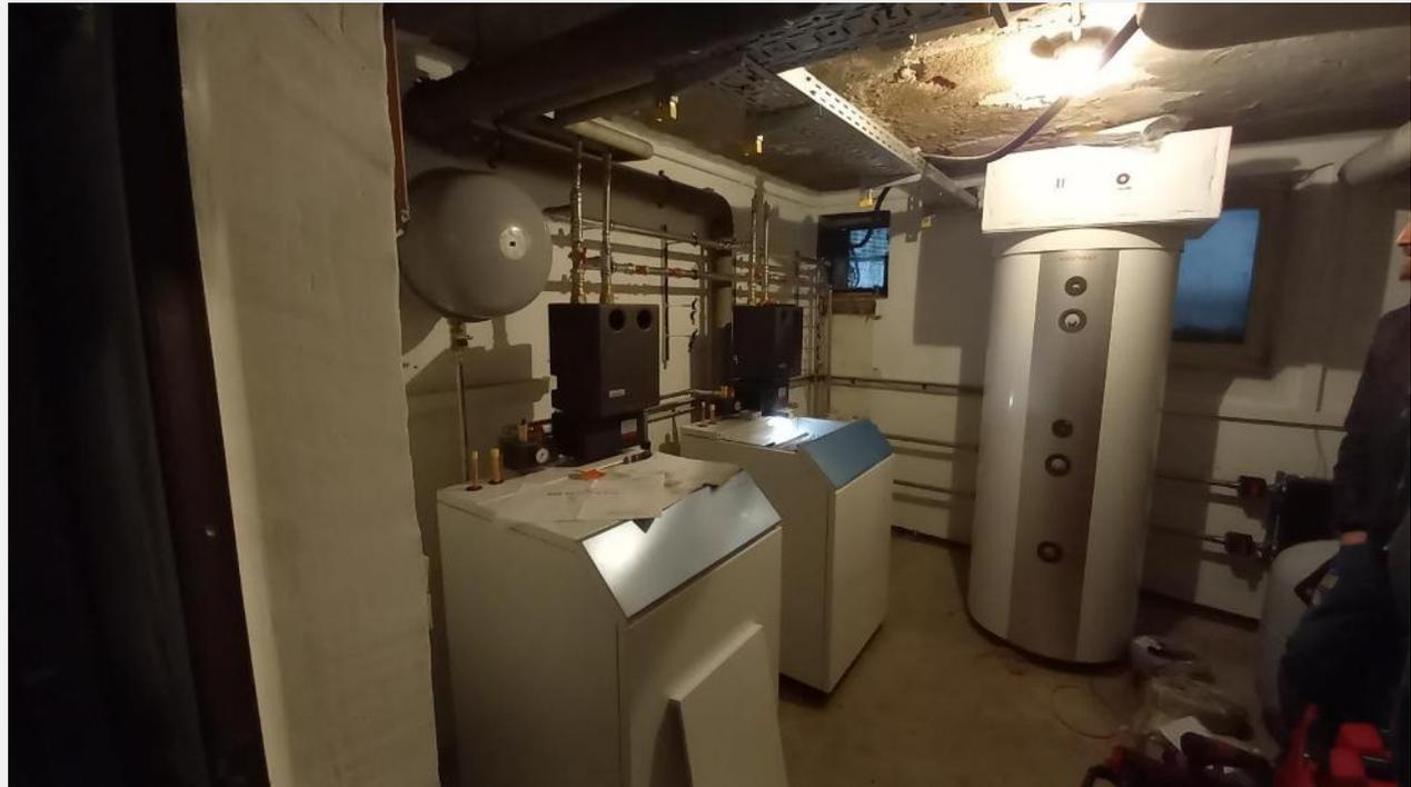
Mehrfamilien-Wohnblock mit Wärmepumpenkaskade (unsanierter Altbau)
