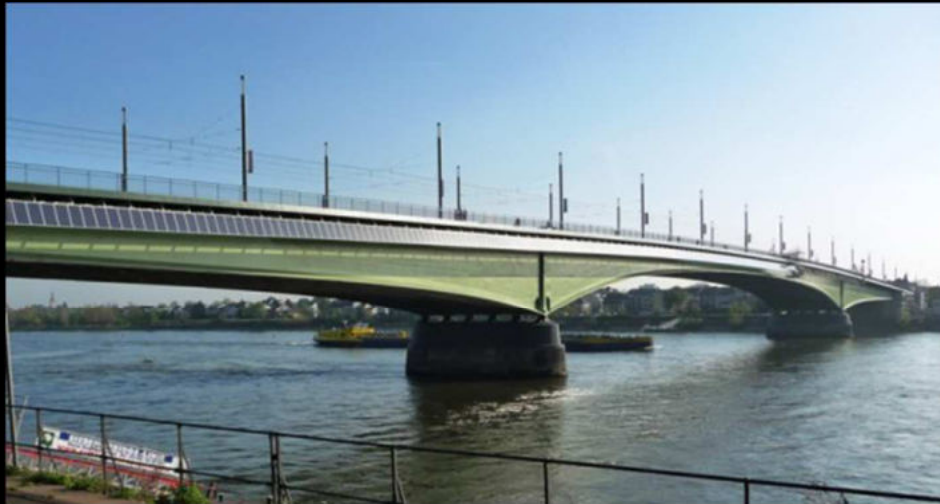
Solaranlagen auf Brücken
